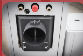
Dimovod i izvodi kotla
